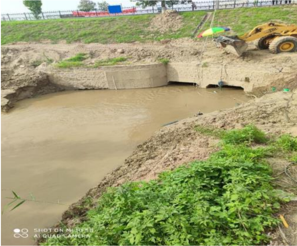
图 2.3-3 东大坝引黄闸闸后现状
