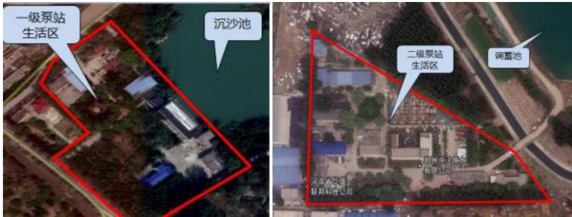
图 2.3-13 一、二级泵站厂区
