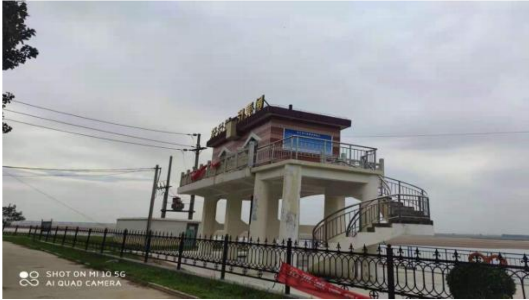
图 2.3-1 东大坝引黄闸现状
