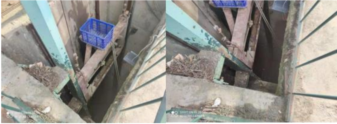
图 2.3-5 水源地引水闸闸门
