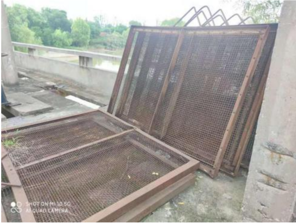
图 2.3-10 水源地一级泵站拦污栅
