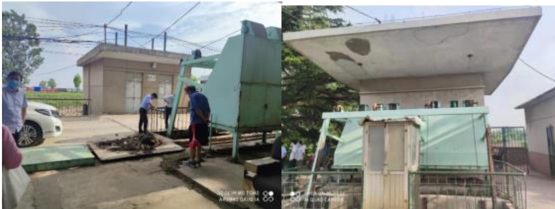
图 2.3-4 水源地引水闸闸室
