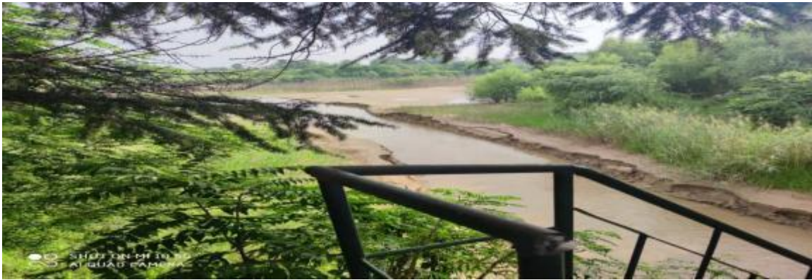
图 2.3-6 水源地引水闸闸后现状
