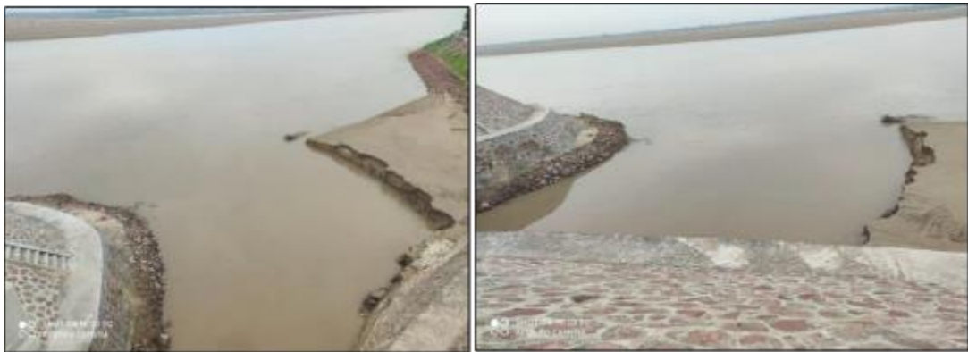
图 2.3-2 东大坝引黄闸闸前
