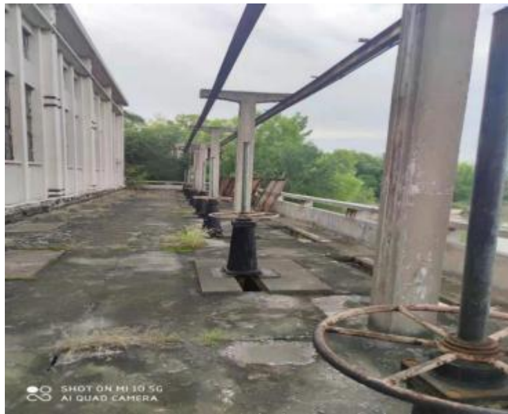
图 2.3-11 水源地一级泵站泵房引水侧现状
