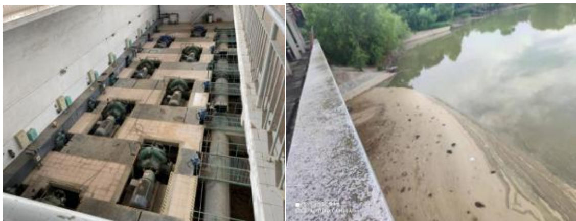
图 2.3-8 花园口水源地一级泵房及泵站进口前现状
